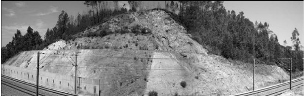
Figura 7 - Fotografia montada do corte geológico causado pela passagem da Linha do Douro.
