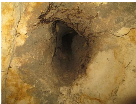
Figura 8 - Chaminé cársica situada no setor sul da gruta.
