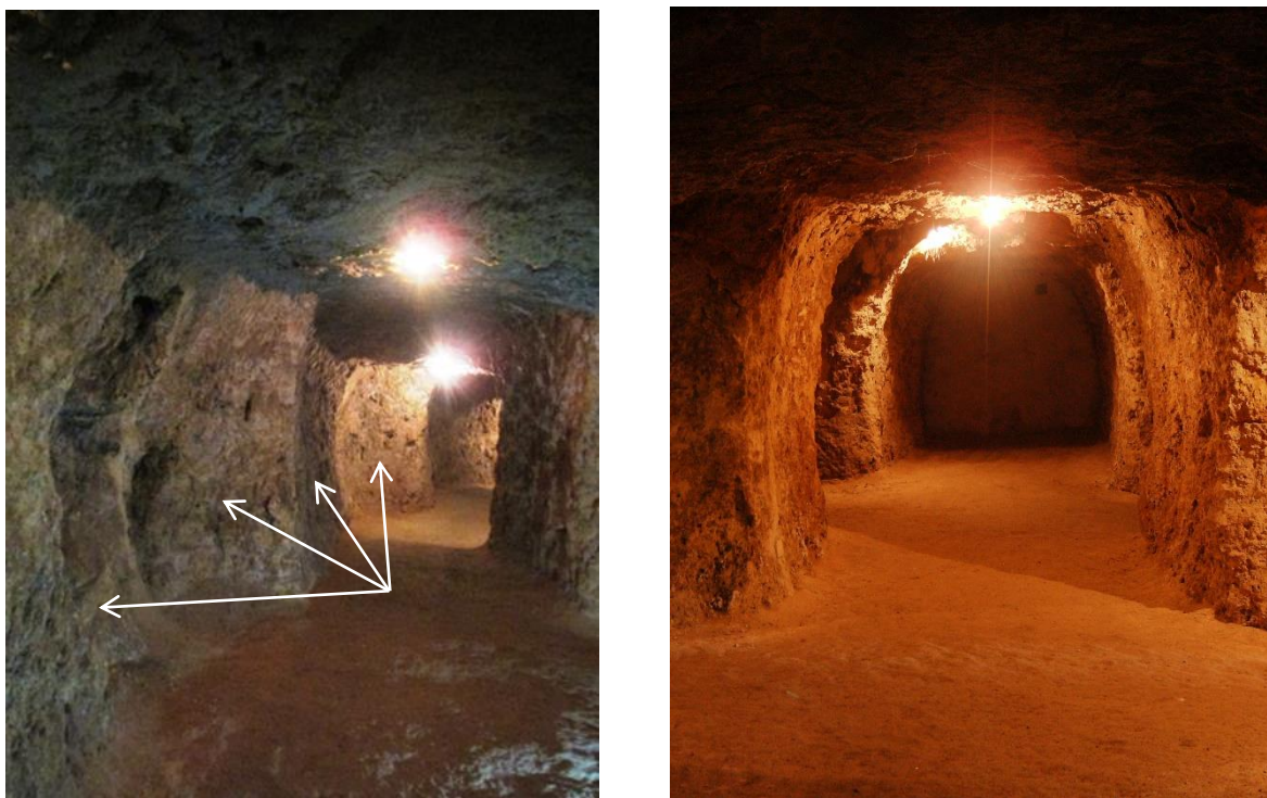
Figura 10 – À esquerda, antigas frentes de corte de tufo (setas). À direita, secções de galerias evidenciando forma subretangular, com o teto claramente paralelo ao chão.
