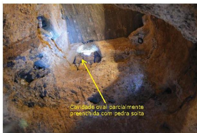
Figura 17 – Zona 6: vista do maciço nas imediações da chaminé CH4
