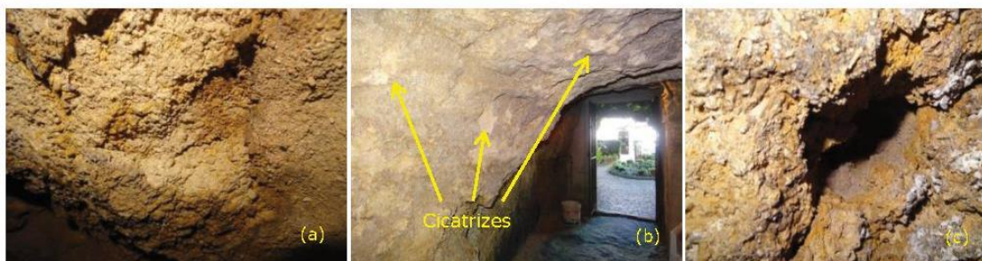
Figura 12 – Zona 2: vista geral das formações ocorrentes: (a) formação com granularidade mais grosseira; (b) formação com granularidade mais fina; (c) exemplo de cavidade resultante do destacamento de material rochoso
