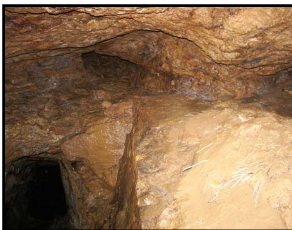
Figura 13 – Fotografia de uma galeria de prospecção recente a intersectar um desmonte de exploração antigo.
