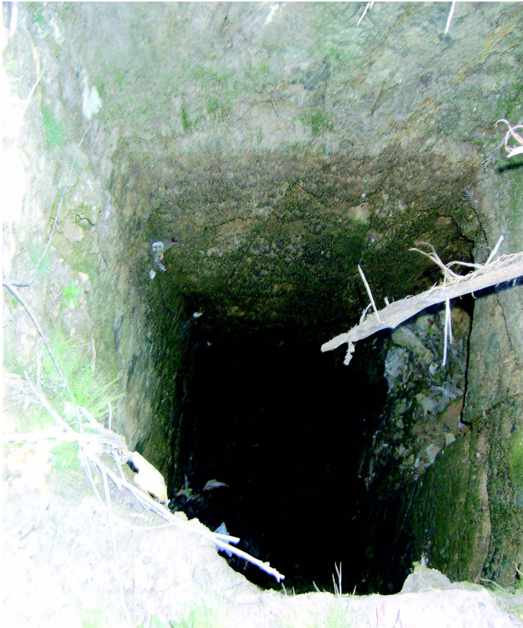
Fig. 5 Poço de secção quadrangular no Couto Mineiro das Banjas.
